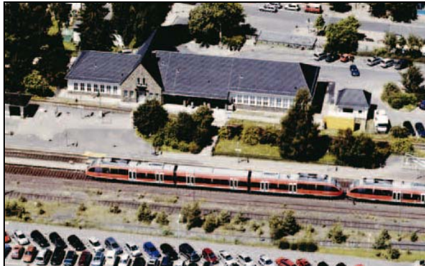
Luftbild des sanierten Empfangsgebäudes
