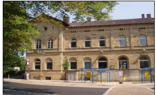
Empfangsgebäude nach der Sanierung
