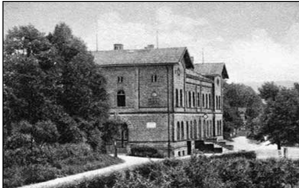
historische Aufnahme des Empfangsgebäudes
