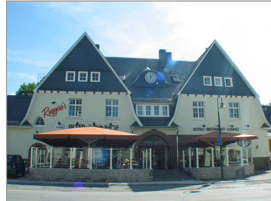
wieder genutztes Empfangsgebäude [Quelle: BEG]
